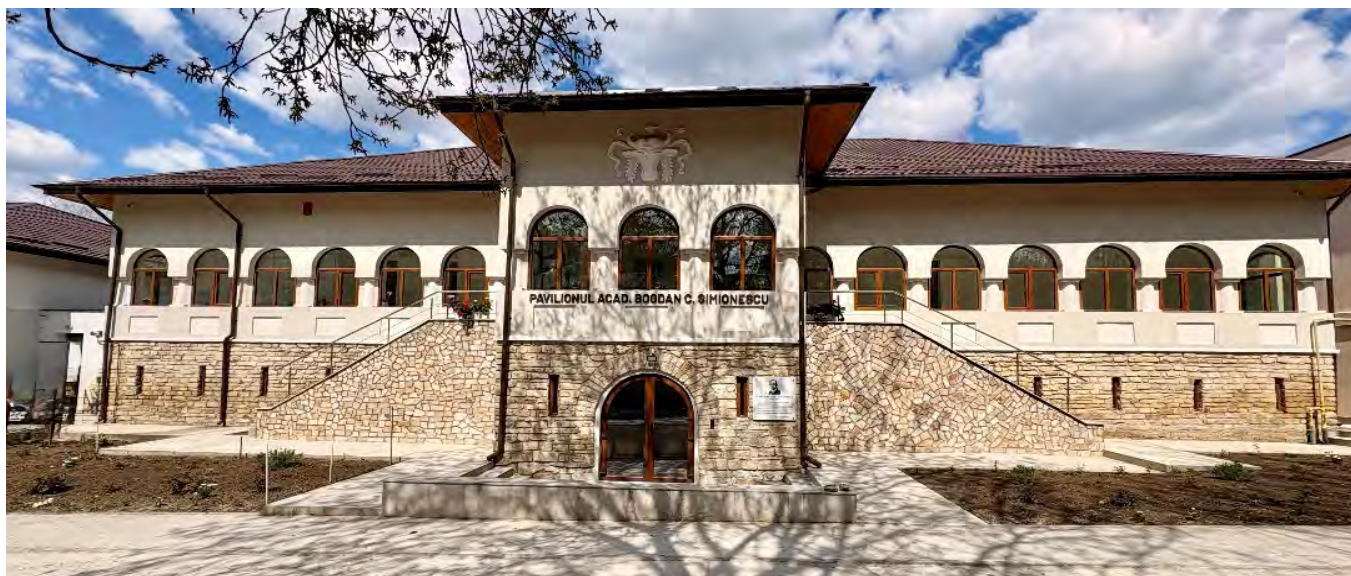
Clădirea „Moldova”, restaurată în 2023 și dată în folosință sub denumirea Pavilion „Acad. Bogdan C. Simionescu”
