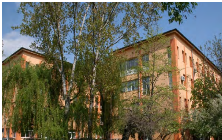
Clădirea sediului actual INCDFT-IFT Iași, din Bulevardul Prof. dr. doc. D. Mangeron, nr. 15, Iași
