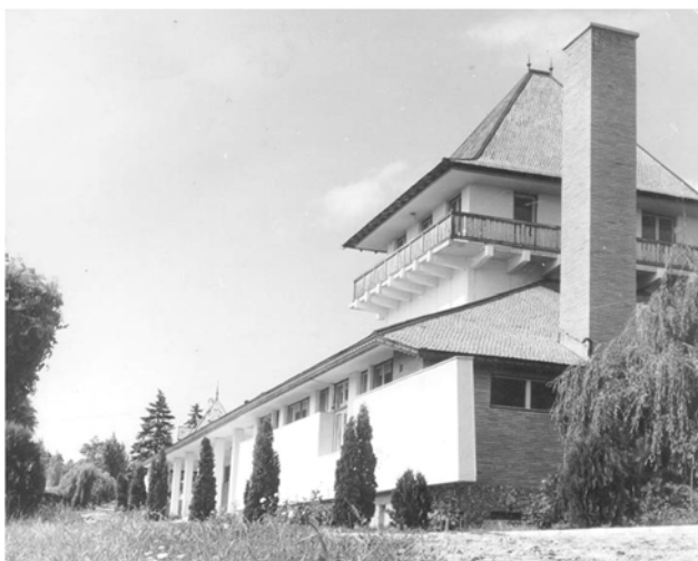
Pavilionul principal (construit în 1969)
