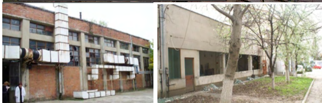
Ansamblul arhitectonic al localului ICMPP; imagine din toamna anului 1974; (a) Hala de piloți și noua centrală termică pe combustibil lichid, funcțională din 1973 (b) Imobilul pentru microproducția de benzi adezive, operațional din 1988
